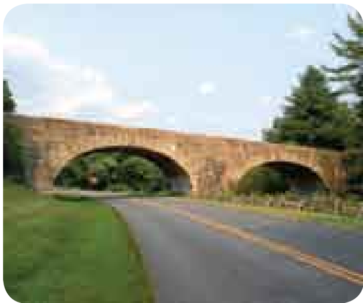
Low Gap Bridge, VA
