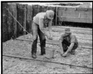
Final Clean-Up of Dam Pour
