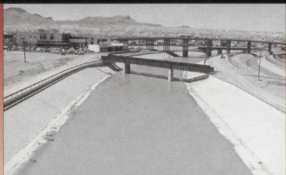
New concrete channel; El Paso (left) and Juárez (right). Nuevo canal de concreto; El Paso (a la izquierda) y Juárez (a la derecha).
