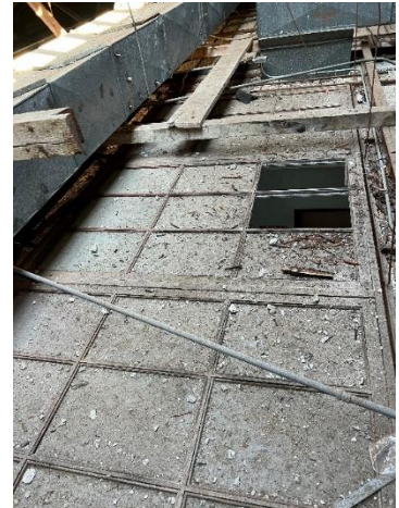
XE.21 Conduit above Lay Lite System
