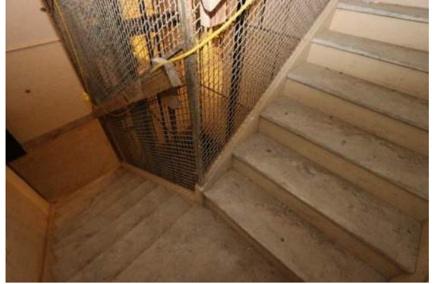
XA.84 – Stair Hall 217.
