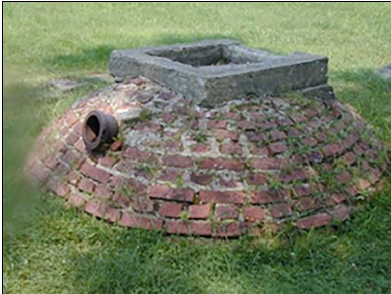
Fig. 32: Cistern (NCR CLP 2016).
