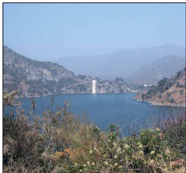
Morris Dam. 2006. NPS photo.
