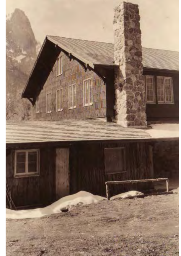
External Chimney, 1935 (YRL 6724).
